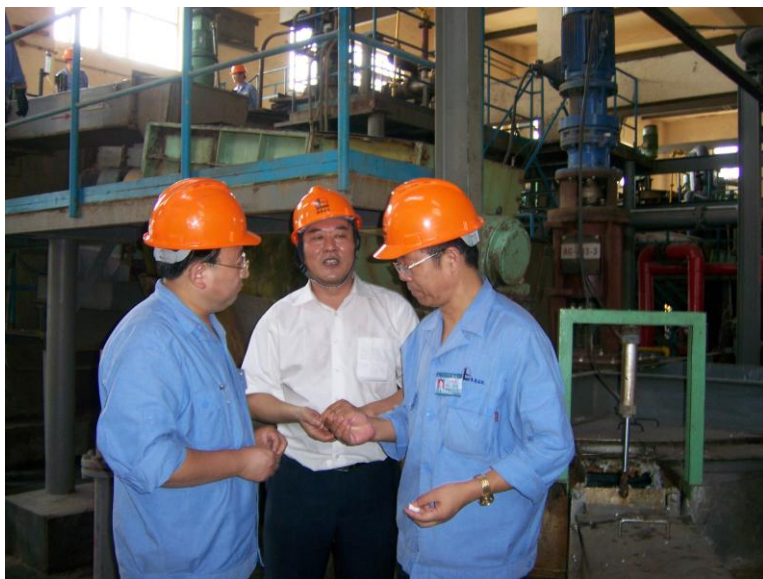
图八：在齐鲁石化橡胶厂进行“丁苯橡胶/纳米层状硅酸盐乳液共沉胶”工业化试验现场（年五万吨装置）照片
